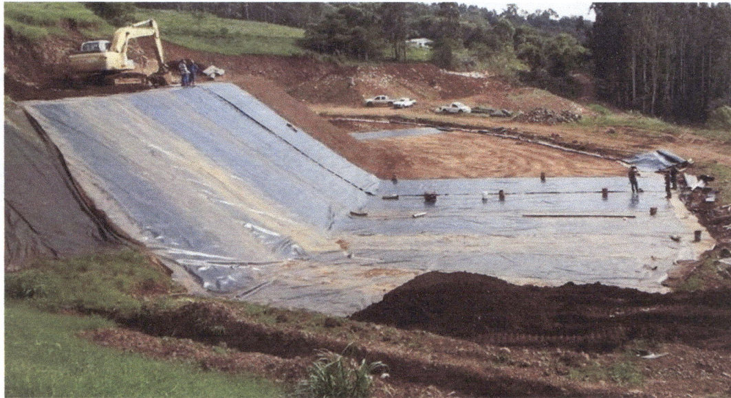
Figura 9 - Impermeabilização do solo
