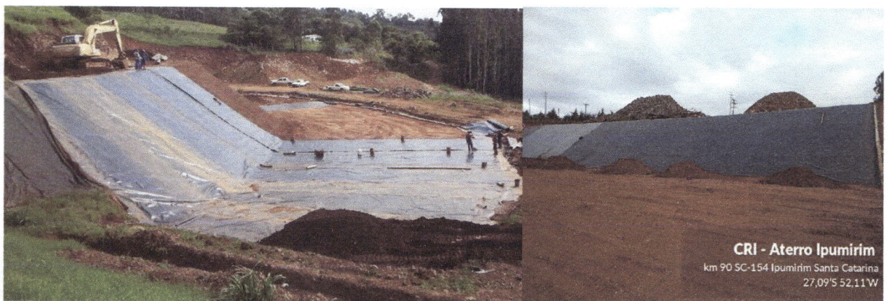
Figura 4 – Impermeabilização do solo (argila e geomembrana)
