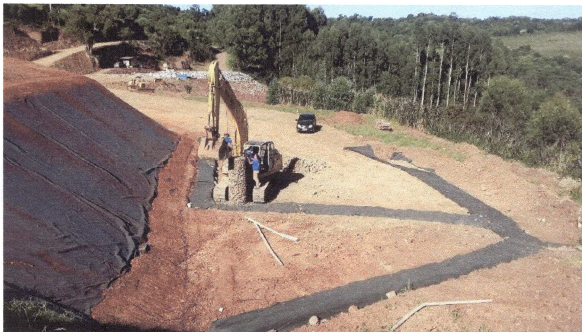
Figura 5 - Construção drenos de chorume
